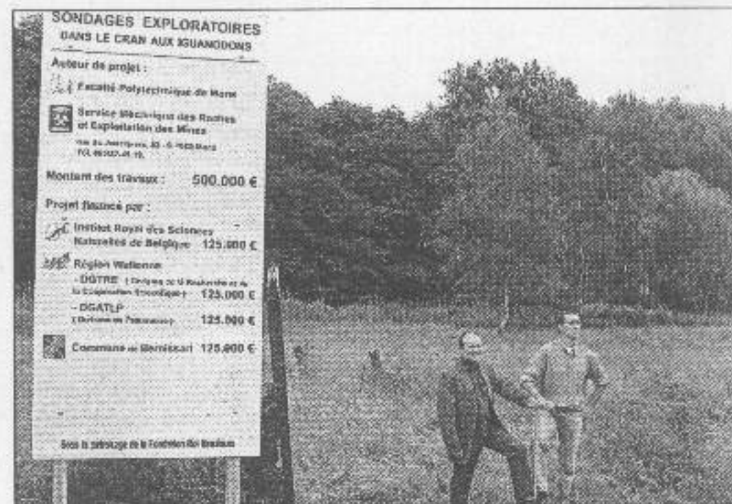
Ce vendredi, le premier coup de pelle des forages exploratoires a été
